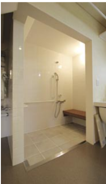
シャワー室は、ユーティリティーとの境に水返しをつけた。シャワーカーテンの裾を長めにし、この水返し部分に張りつくようにすることで水が流れるのを防ぐ
