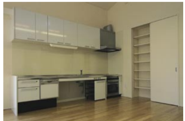
キッチンは、樋口がフルオーダーで対応。右斜め45度から使うのが使いやすいという奥さまの要望に応え埋め込み式の食器棚、IH、シンク、食洗機と動線が右回りで完結するようになっている。車いすからでもレバー式水栓に手が届きやすい位置に水栓も移動している
