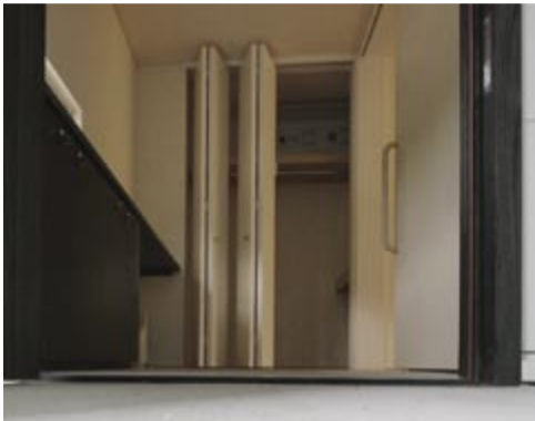
風除室から玄関を見る。地面すれすれについている黒いゴムが防水パッキン。カウンターの高さは車いすの手すりの高さよりも若干高くしており、方向転換をするときに邪魔にならないようにしている
